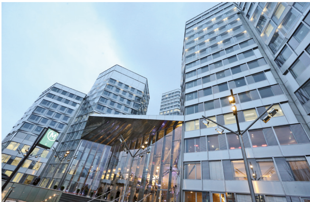
■ Des postes en insertion ont été notamment proposés sur les chantiers de rénovation des tours CityLights.
