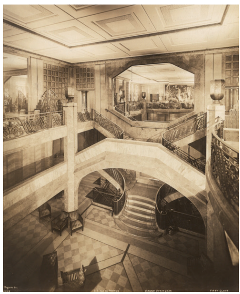
Byron Company Collection. Grand escalier de la 1 re classe 1927-1939. Tirage argentique.
