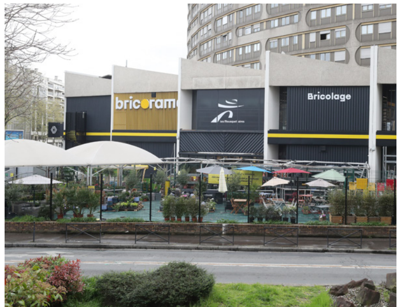
■ Une façade plus épurée et un vrai parc arboré de part et d'autre de l'entrée embellissent les abords du Bricorama boulonnais.
