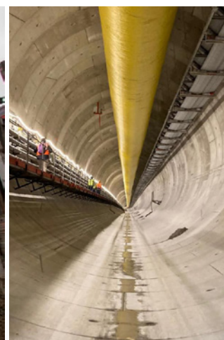
■ Le tunnel de la ligne 15 sud.
