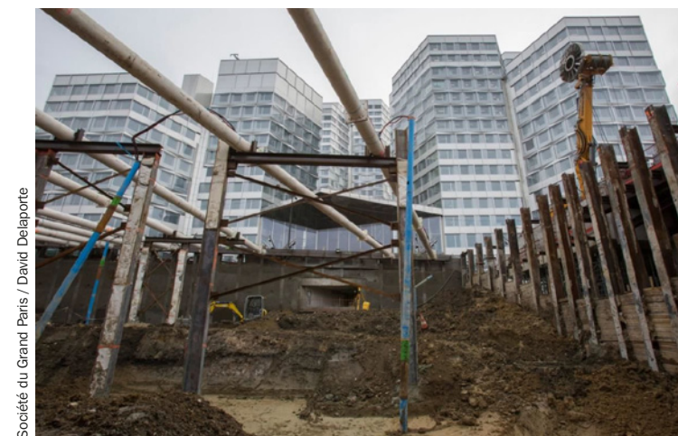
■ Le couloir de correspondance vers la ligne de métro 9.
